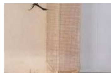
「131」 養生テープ（白） 布ガムテープ
