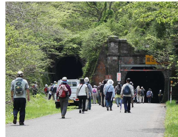
【山中トンネル】
