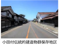
小田付伝統的建造物群保存地区
