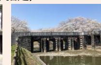
加治川分水門
