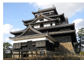
松江城天守の木製格子壁による補強
