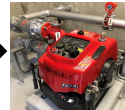
老朽化した消火ポンプの更新
