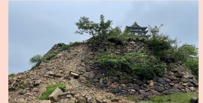
整備が遅れて石垣が崩落
