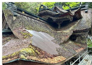
檜皮葺屋根の経年毀損 (金属板にて応急処置) 【重要文化財 大瀧神社本殿及び拝殿 (福井県越前市)】
