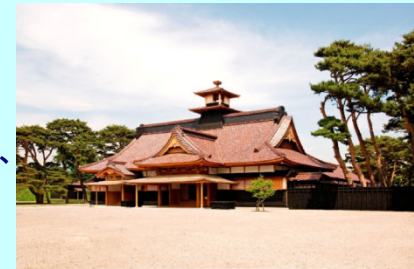
特別史跡 五稜郭跡内 箱館奉行所復元整備（北海道函館市）
