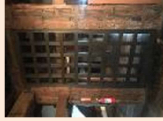
耐震対策工事（松江城天守） 左：格子壁補強 右：鉄骨フレーム
