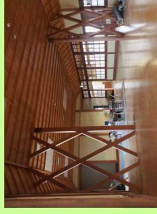
耐震対策装置の設置
