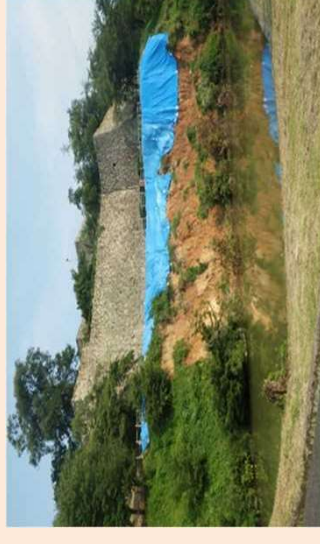
被災事例（史跡津山城跡） 城郭公園内の遊歩道下の法面が崩落。
