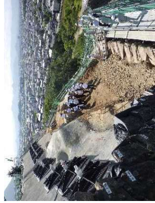
災害復旧工事の状況 (斜面保護のアンカー施工) 史跡「丸亀城跡」 (香川県丸亀市)
