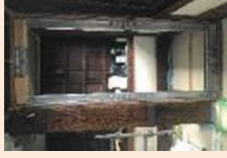
耐震対策工事（松江城天守） 左：格子壁補強 右：鉄骨フレーム
