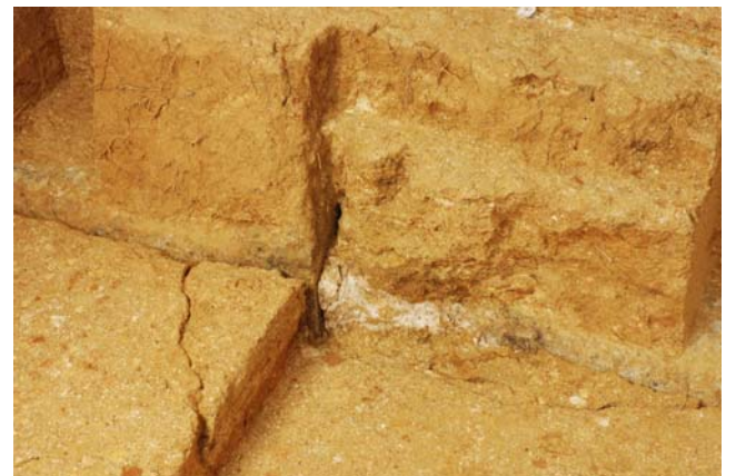
8 天井石に沿う亀裂と根（天井石3・4）
