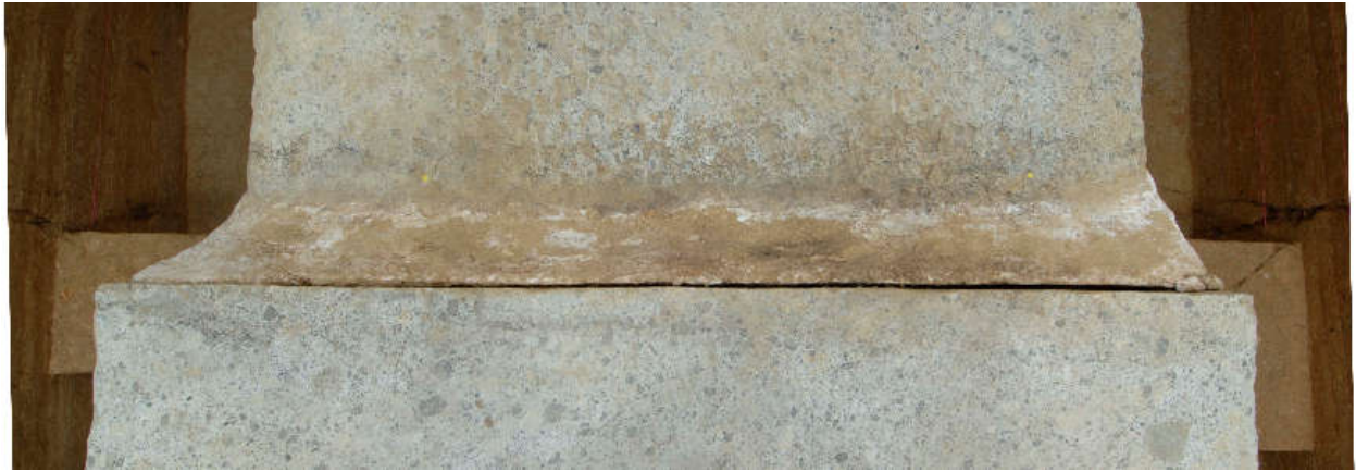
9 天井石 3・4間接合部上面に生じた漆喰の隙間
