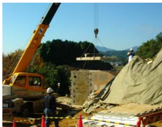
クレーンでPCを吊り上げる(11/14)
