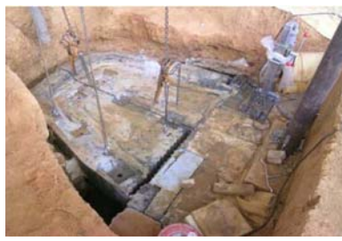
10：塞ぎPC版を撤去しPC版底を切断
