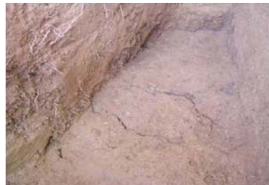
6：埋め戻し土に生じた地割れ
