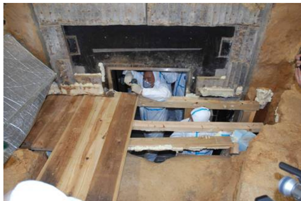
8：取合部仮養生施設の撤去
