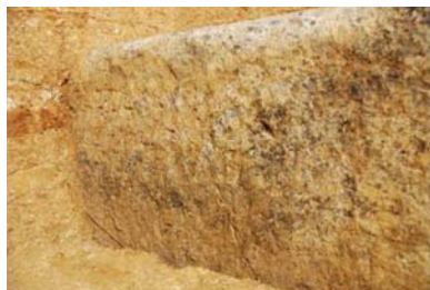
57 : 天井石3東側面の亀裂
