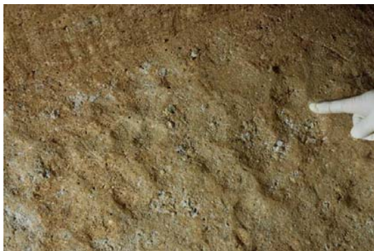
69 : 作業面に残る搗棒痕跡
