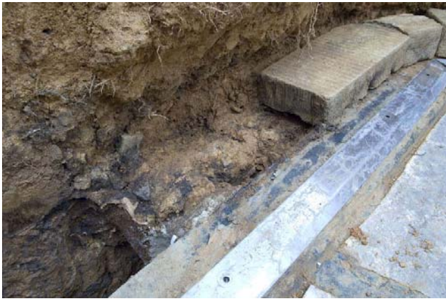
1 PC版周囲をふさぐ凝灰岩設置面の状況
