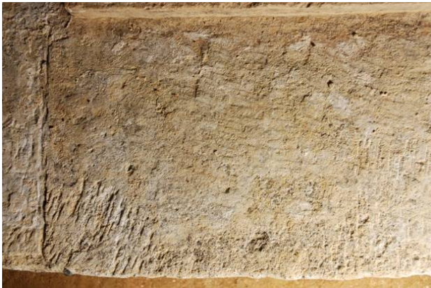
75 : 床石上面の加工痕跡
