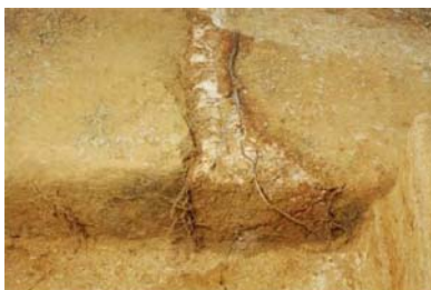
56 : 天井石の継ぎ目に伸びる根
