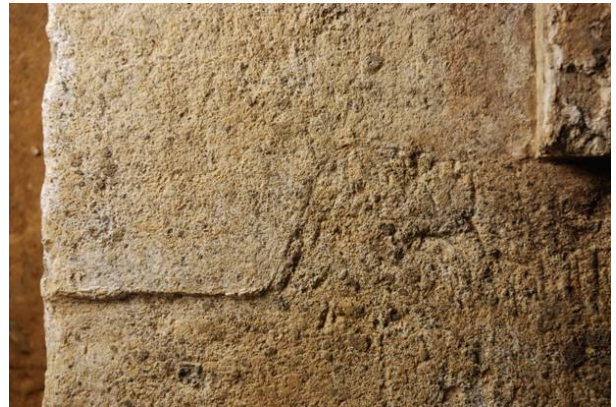
76 : 床石上面の加工痕跡 (西壁石 1 と閉塞石接着部)
