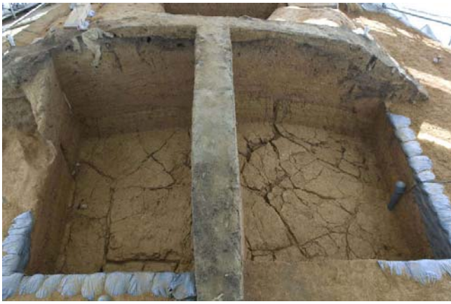
1 下部版築層の亀裂
