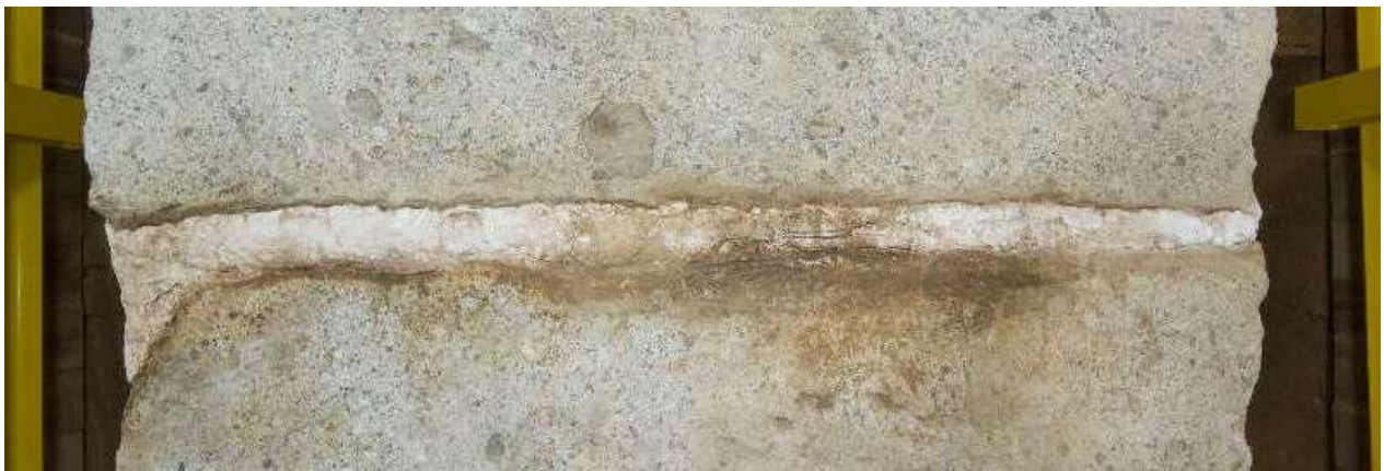
11 天井石 1・2間接合部上面に生じた隙間とカビ・根
