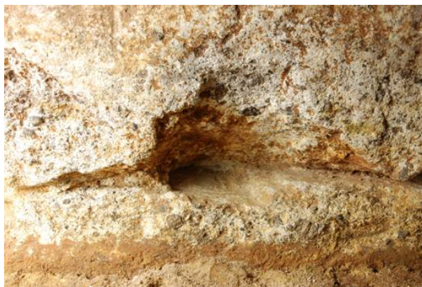
42：閉塞石下端のテコ穴
