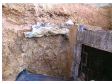
12：取合部のカビと平成15年崩落止めウレタン
