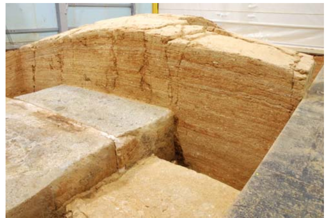
6 白色版築層東西断面の亀裂（天井石2上部）
