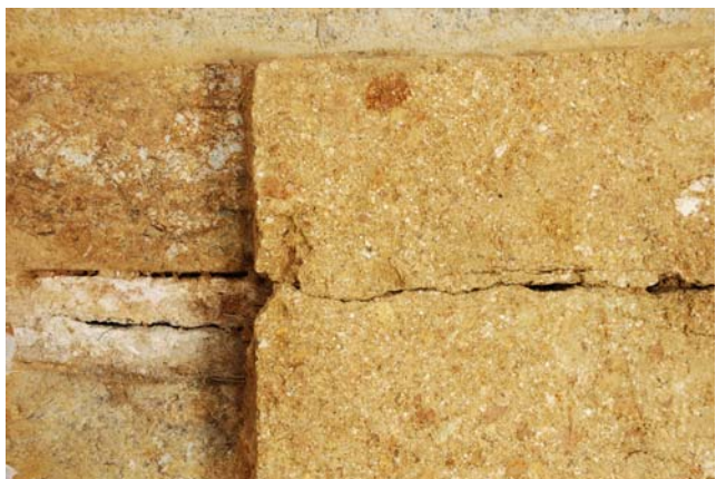
7 天井石2・3接合部からのびる亀裂
