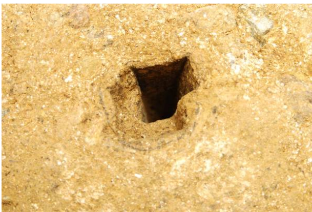
53：空洞化した水準杭の腐朽痕
