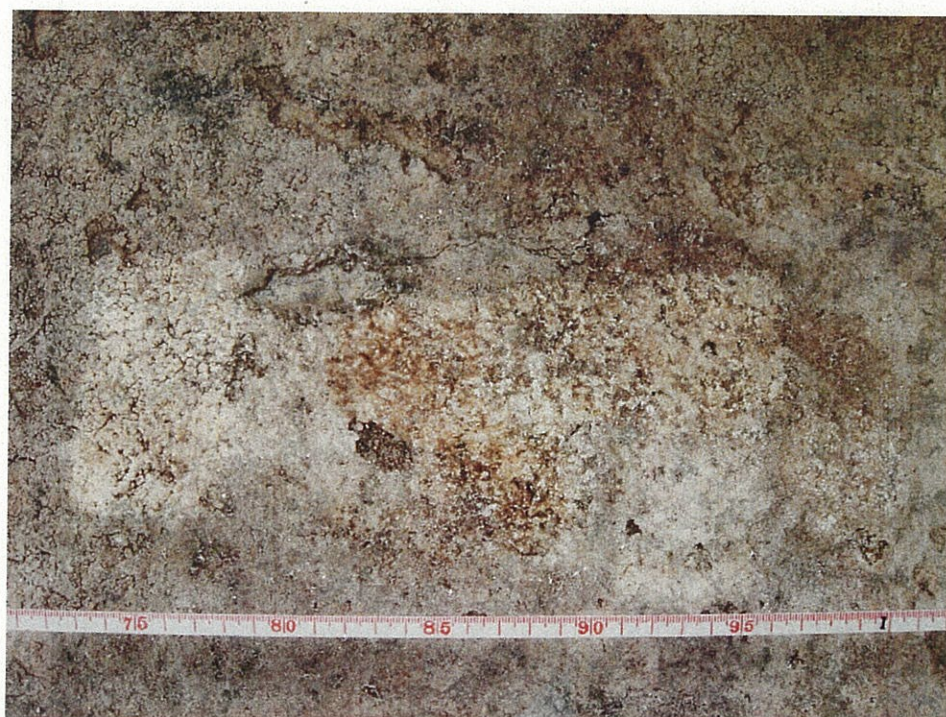
写真 12 天3クリーニング作業箇所（部分）
