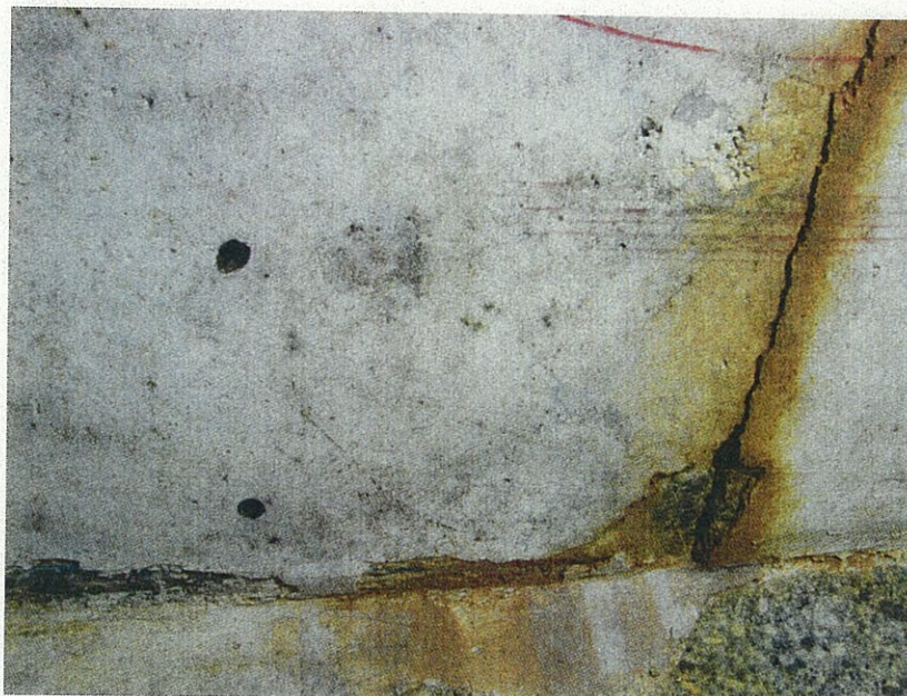
写真 1. 2005 年 9 月 29 日 天井の穴（直径およそ 1 c m）の例
