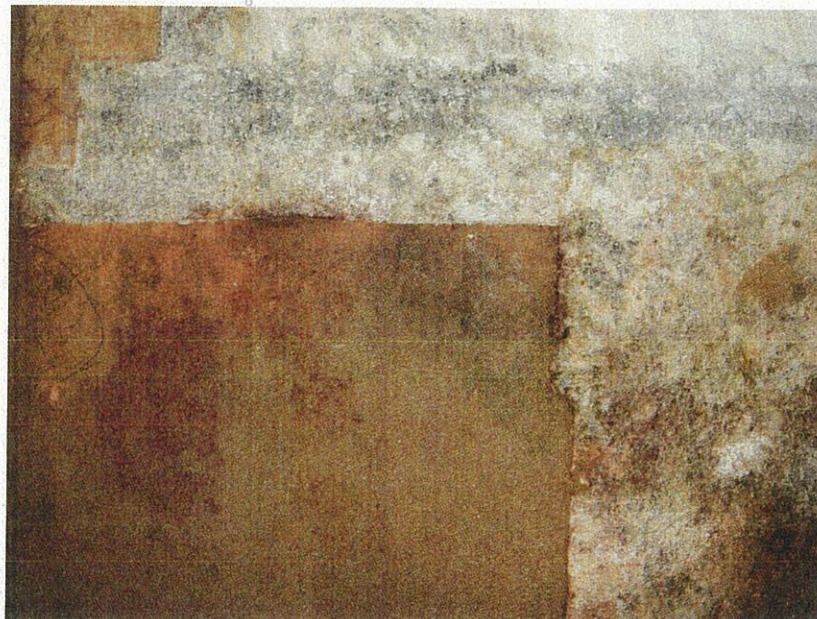
写真4. 2008年8月22日 キトラ古墳南壁（部分）
