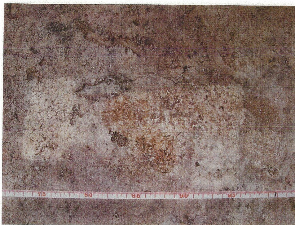
写真 12 天3クリーニング作業箇所（部分）
