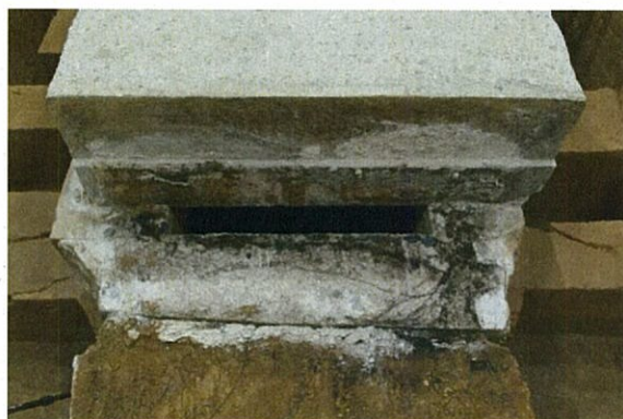
図26 石室石材の接合面に確認されたカビを含む黒色の汚れ（北壁石上面）
