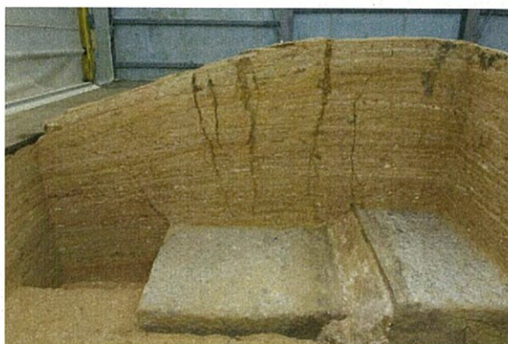
図 24 版築層を突き破る多数の地割れ （版築層南北断面。右が南。）
