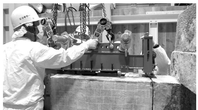
図⑤-6. 治具を設置した後、チェンブロック操作により地切りを開始
