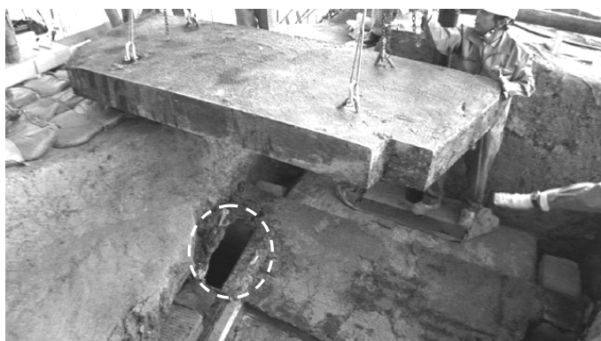
図 4.1 押さえ石を吊り上げた状態（東側に開いた空間が見える）
