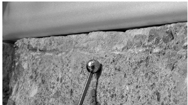
図 3.2 東壁石 2 の側面上部には亀裂が見えないが、全体にわたって広範囲で浮きが発見された。
