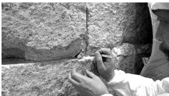
図 5.3 遊離した石材片を最終点検の段階で取り除くこともある。
