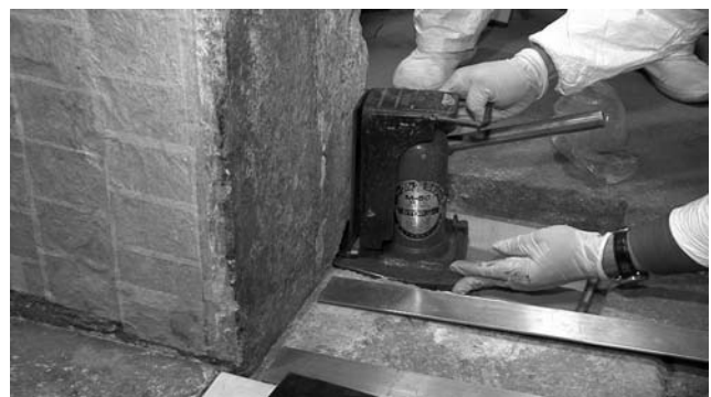
図④-3 石材底部に下方のジャッキを取り付け
