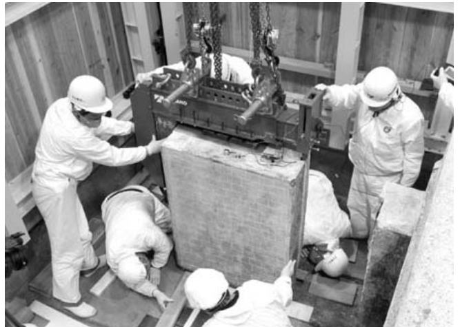
図⑤-8. Γ型治具による移動終了
