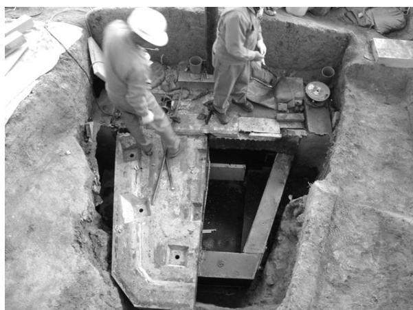
図 4.4 底スラブ PC 版（西）の取り上げ後
