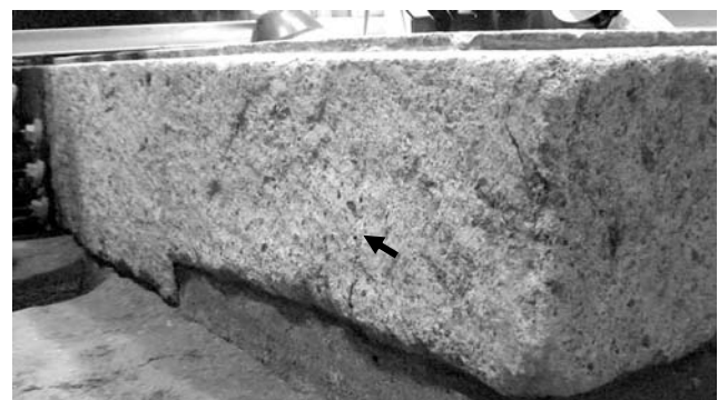
図⑬-2 床石 4 の側面に見られる亀裂
