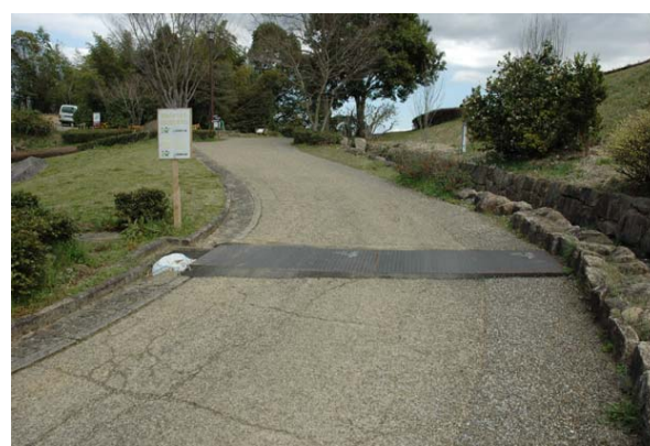
図 14 走行経路における段差の解消
