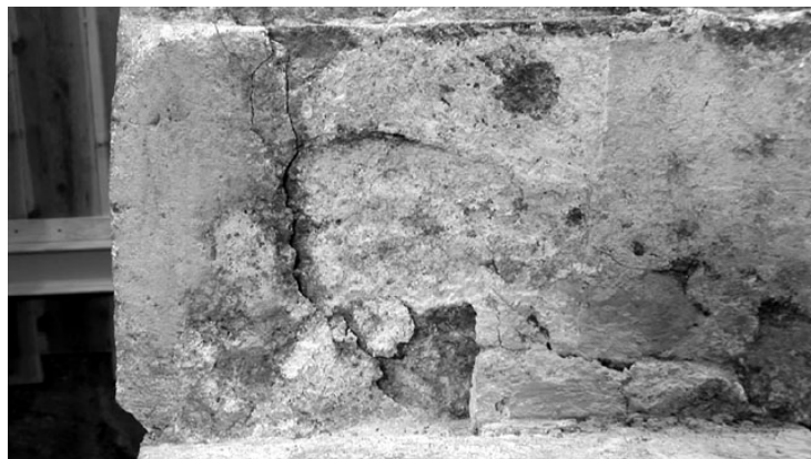
図 4.7 天井石2の北面東側に見られる亀裂状態と東壁石2の接する部分は漆喰によって固着していた。
