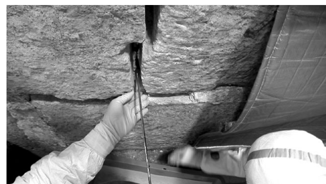
図③-2 相欠き間に残存する目地止め漆喰の除去
