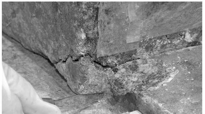
図⑤-4 地切り時に損傷が予想される遊離した石材片を取り除く
