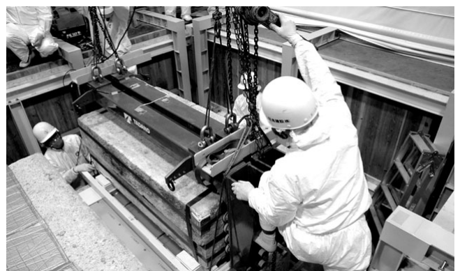
図③-9 石材とフレーム枠下台を一体化する
