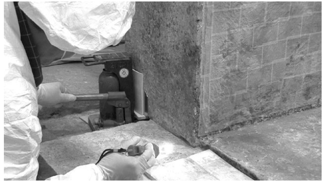
図⑤-3. 地切りの前段階の操作として、ジャッキアップによる遊離石材の取り出し。
