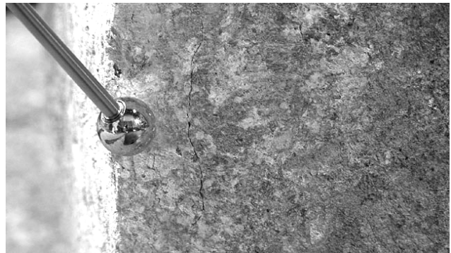
図 3.1 東壁石 2 の南コーナー付近に見られる亀裂部分から亀裂のない部分に浮きが発見された。
