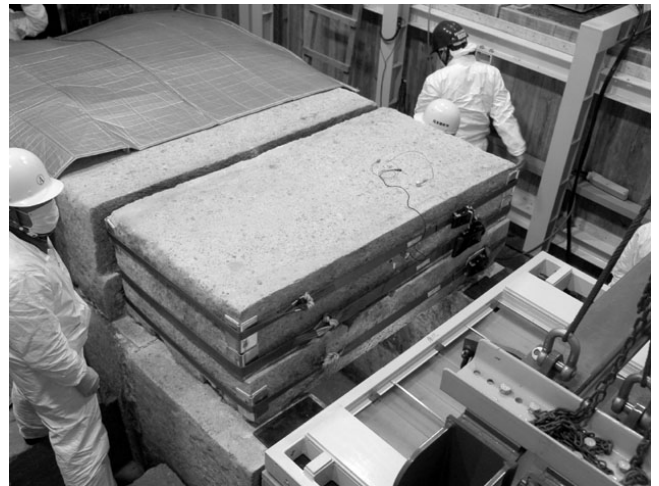
図③-6 亀裂ブロック固定のためのベルトによる拘束
