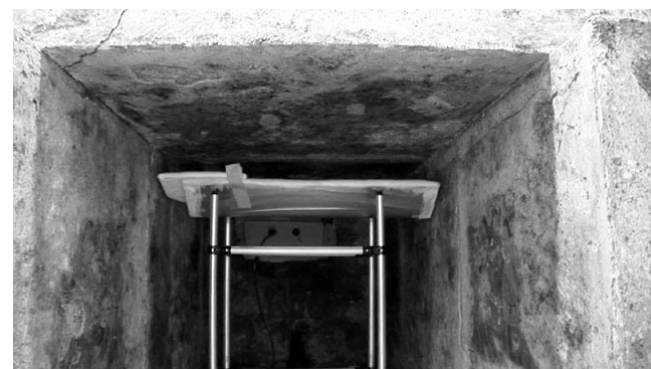
図③-3 落下物の受け皿を石室内に配置する
