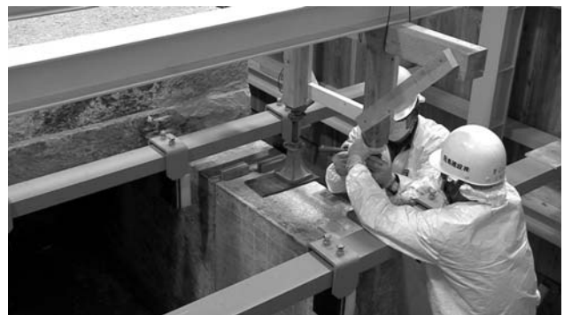
図④-2 石材上部に上方のジャッキを取り付け
