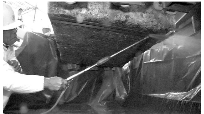
図⑬-6. 高圧シャワーを用いた底面の洗浄処置
