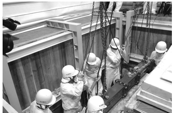
図②-5 地切りの開始は、チェンブロックによる
