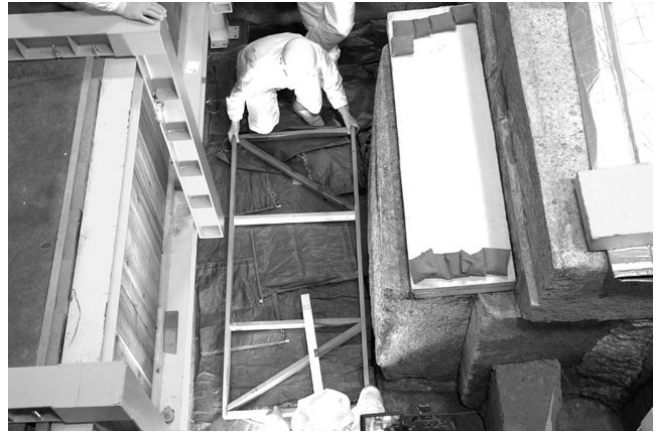
図②-4 石材を梱包するフレーム枠の下台を設置するスペースを検討する
