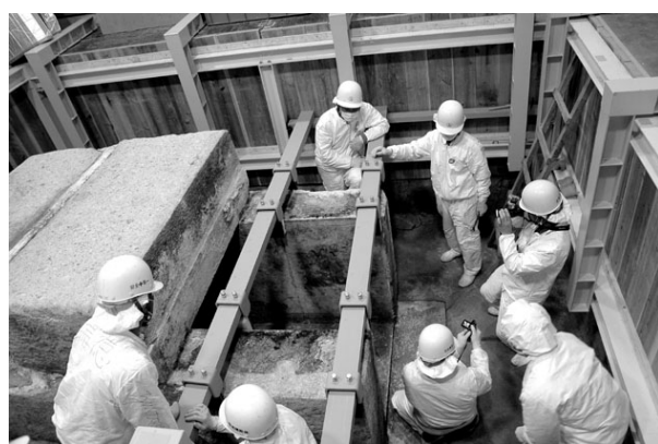
図③-14 天井石 3 を取り上げた直後に倒壊防止対策をおこなう。東西の土留め鋼材を利用して、東西壁石 3 を支えられるように、それぞれの石材を挟み込むような方法によった。壁画面については 5 cm 壁面から距離をとっている。
