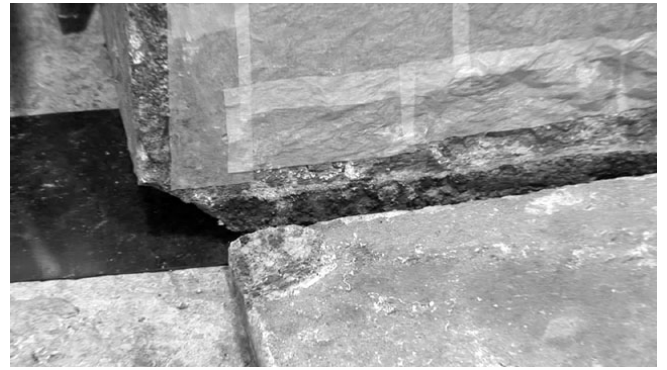
図⑤-7. 相欠きが外れて北、東へと石材が離れる
