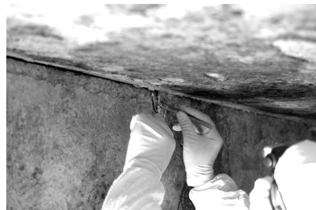
図③-4 壁画面上部の遊離石材の取り外し
