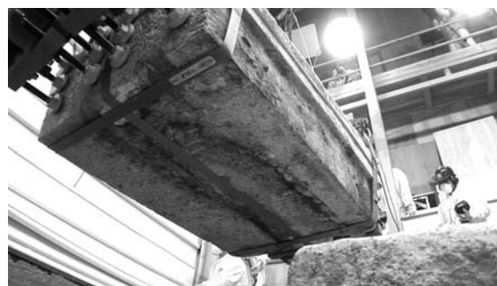
図①-6 石材が取り上げられて移動
