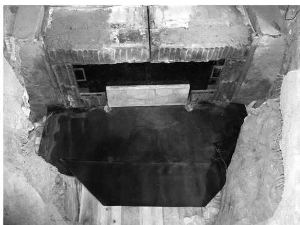
図 4.7 PC 版がすべて撤去された状態
