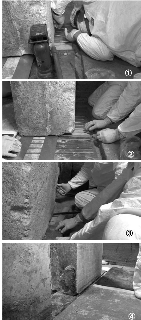
図④-4 ステンレス板の間にコロを挿入してコロレール上を石材がゆっくり移動
