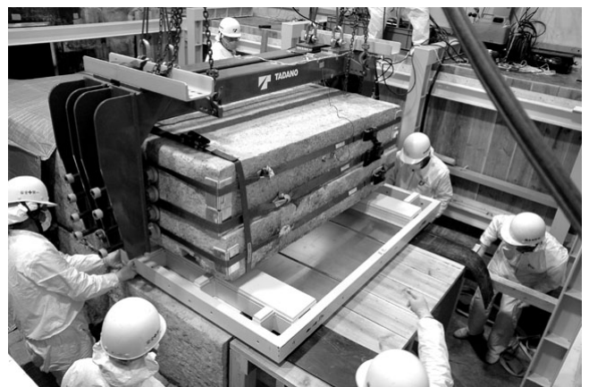
図③-8 石材をフレーム枠下台へ取り付ける
