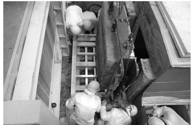
図②-7 梱包の第一段階では、石材を移動して下台フレームに設置する
