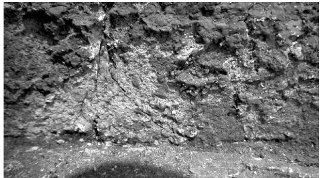
図④-1 西壁石 2 と西壁石 3 の境界に見られる三角形を呈する亀裂
