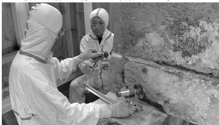
図 4.8 地切り時に固着部分を取り外す必要があるが、発生していた亀裂部分が耐えられずに、ブロック状となって石材が脱落する危険が予想された。その対策として事前に、ワイヤーソーを用いて固着している部分を切り離した。
