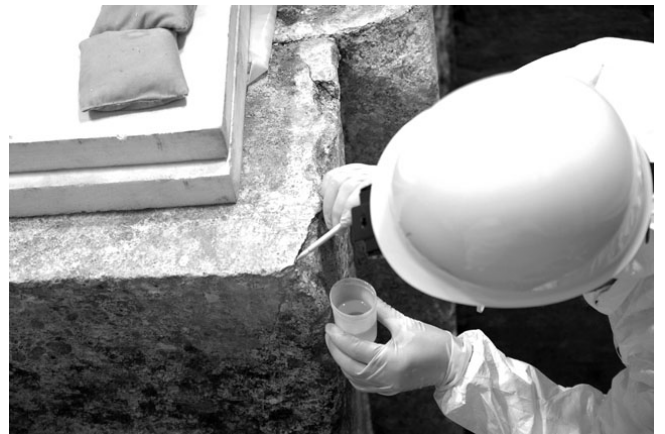
図②-2 遊離石材片を取り除いた後に、アクリル樹脂による破断面の強化処置を実施した
