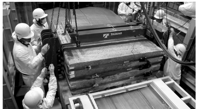
図③-7 チェンブロック操作により地切り
