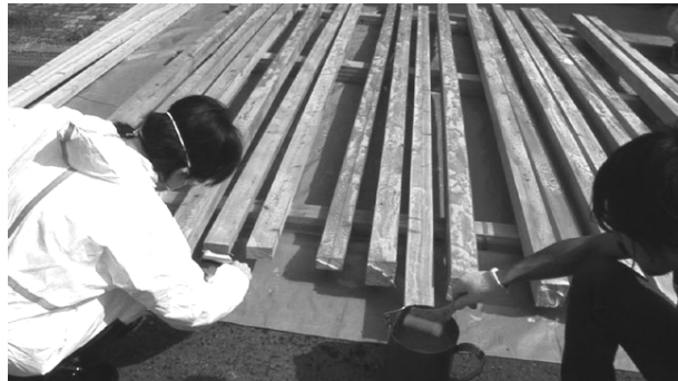
図 2.1. 取合部に使用する材木の防黴処理
