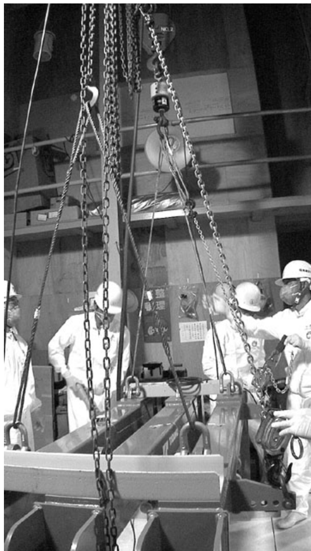
図⑬-4 治具にすべての器具を装着して、重量測定をおこなった。
