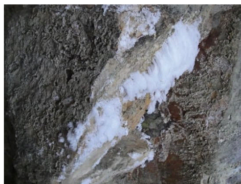
図1 上：塩の析出により表層が剥離した磨崖仏、下：塩析出箇所（拡大）
