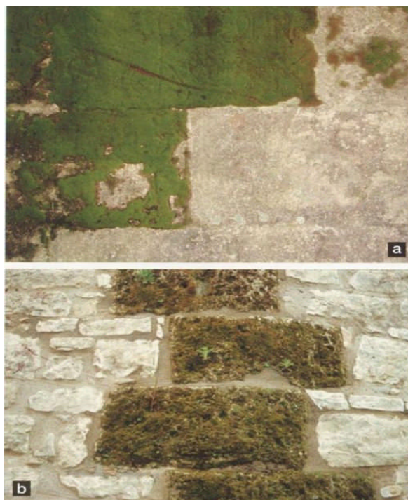
図1 表面状態の異なる石材における生物の発育状況。同じ環境に置かれても石材の種類や表面状態が異なると生物の発育状況（生物受容性）も異なってくる。写真 (a) 緑藻類: J. Izco Sevillano, (b) コケ類と草本類: G. Caneva 3)
