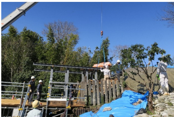
図 1 崩落石材の取り外し作業
