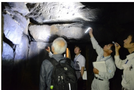
図8 古墳損傷チェックシートの活用（史跡弁慶ヶ穴古墳）
