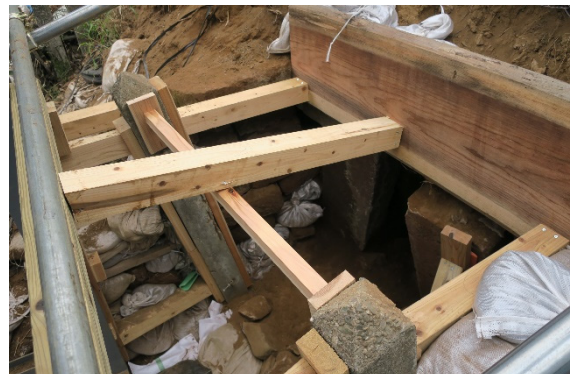
図 2 支保工設置状況
