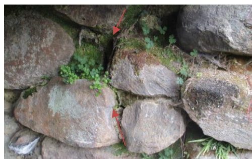
写真 24 石材のずれにより生じた隙間
