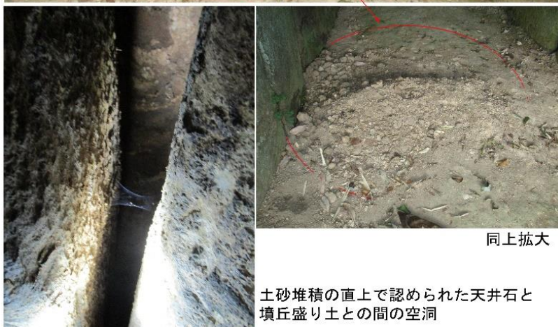
写真 85 大野窟古墳における墳丘の乾燥による土砂の崩落
