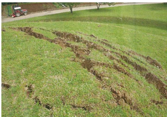
写真 35 三段塚古墳（墳丘の亀裂）（熊本市提供）
