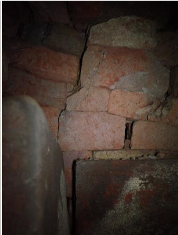
写真 51 玄室北側壁面（石材破碎・脱落）
