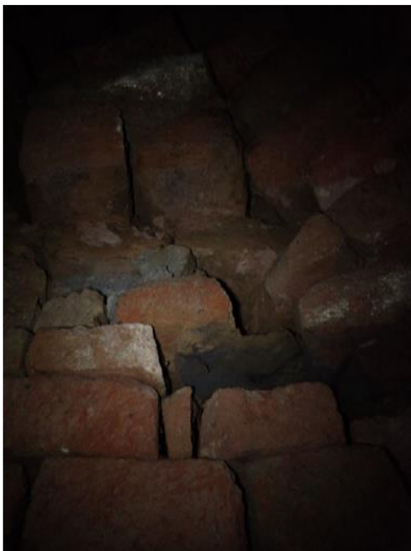
写真 48 玄室南側壁面（石材破碎・脱落）
