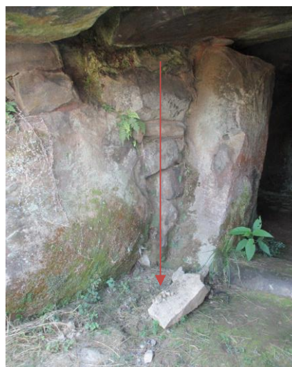
写真 25 前室石材の転落
