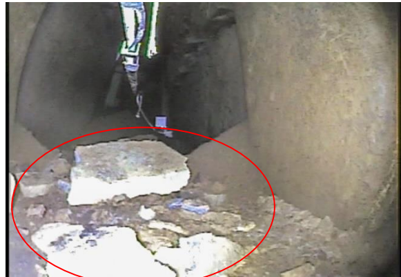
写真 12 同羨道部の石材転落（玄室側から）
