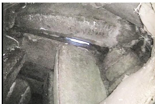
写真 44 石室内の状況（羨道部天井に生じた隙間）
