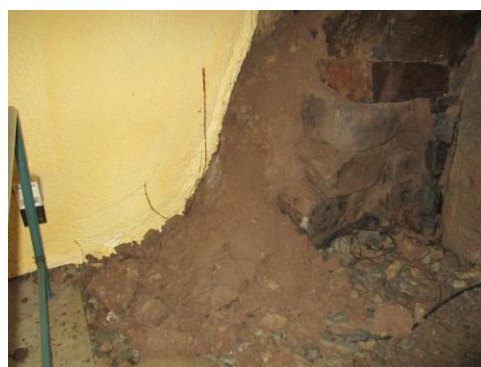
写真 31 裏込め土の流出
