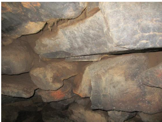
写真 27 御霊塚古墳玄室側壁の様子 ※石材の隙間から土砂の流入や石材の剥離が確認できる。
