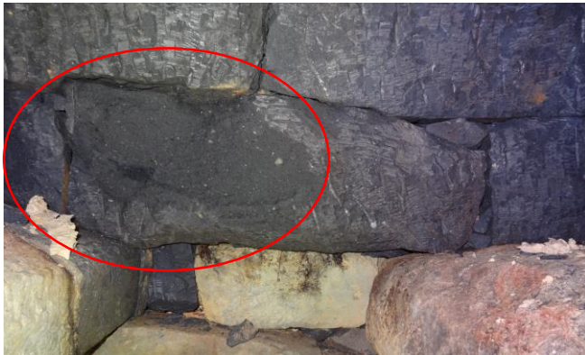
写真 60 石材の剥離
