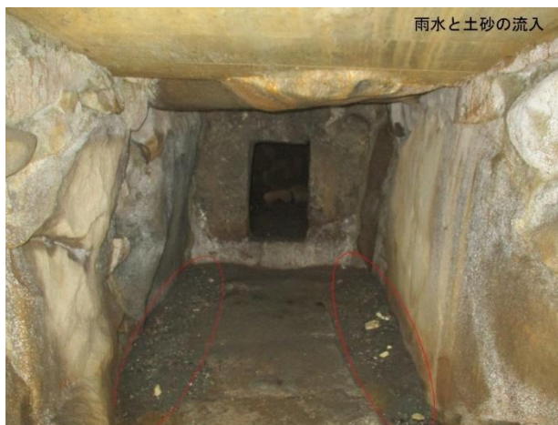
写真81 桂原古墳に認められる雨水浸入の形跡
