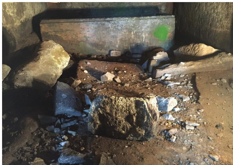
写真 54 床面に転落した石材（氷川町提供）
