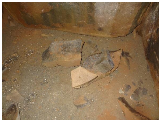
写真 66 石材の転落
