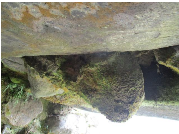
写真 23 羨道天井の石材のゆるみ（28 年 12 月）
