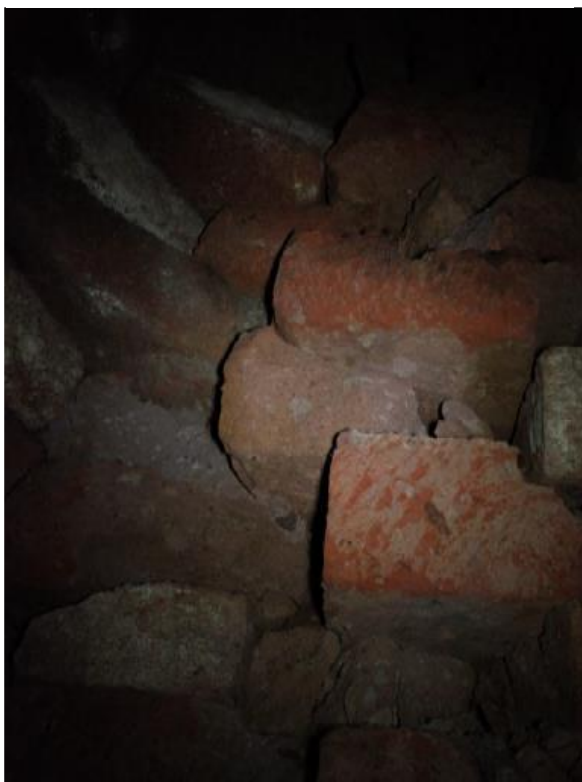
写真 50 羨道南側壁（奥壁側）石材破碎・脱落
