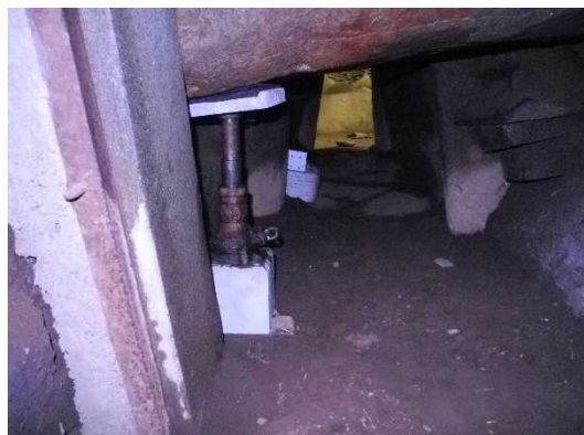
図6 進入路を確保した羨道と前室
