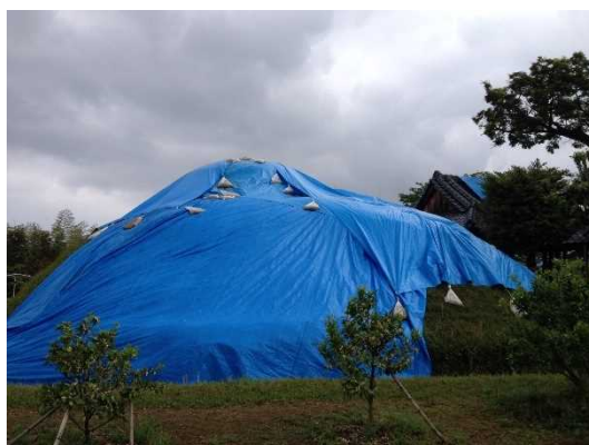
図 4 ブルーシートによる墳丘養生
