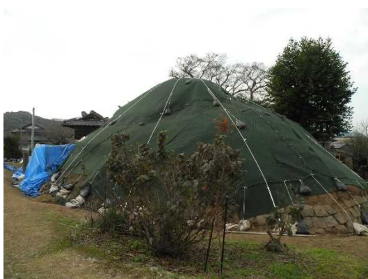
図9 防草シートによる墳丘養生
