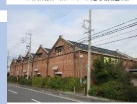
旧東洋紡績富田工場原綿倉庫
