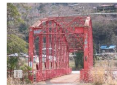
復原前の森村橋
