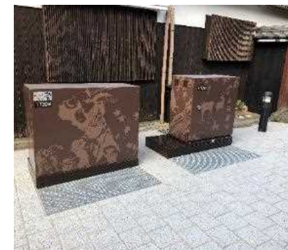
（写真上・左下：無電柱化整備状況、右下：地上機器）
