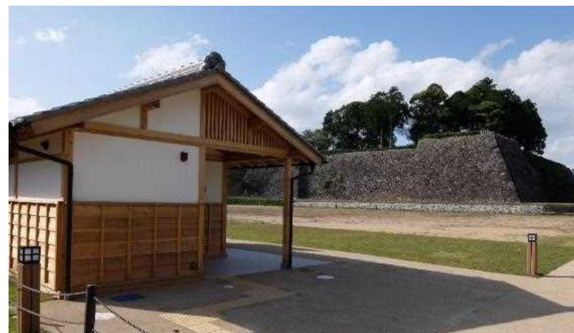
(整備したトイレ[手前]と内堀石垣[高石垣の下])
