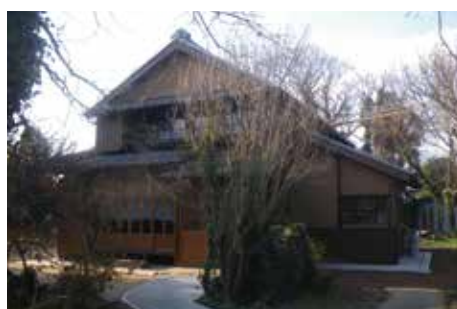
竣工写真（東面）
