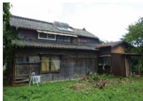
南面の修理前写真
