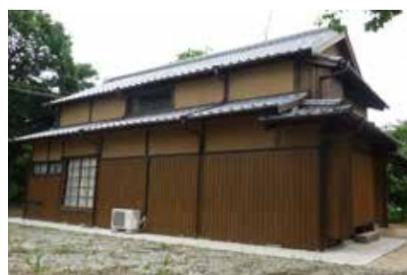
竣工写真（南面）
